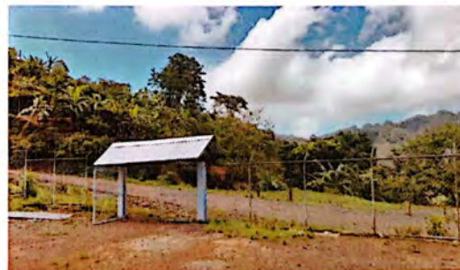
foto 6: sustitucion de porton terminado
