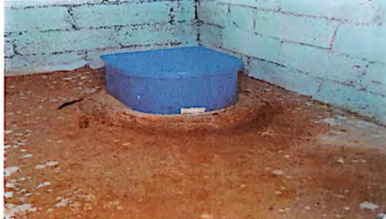
foto 4: letrina colocada en el lugar respectivo
