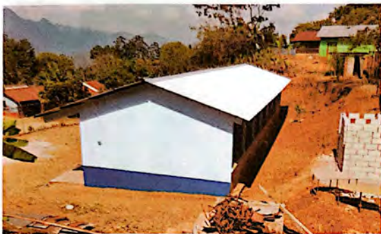
foto 1: en esta imagen se observa el techo colocado y completado al 100%
