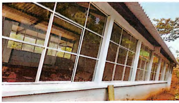
foto 2: sustitucion de ventas con vidrios
